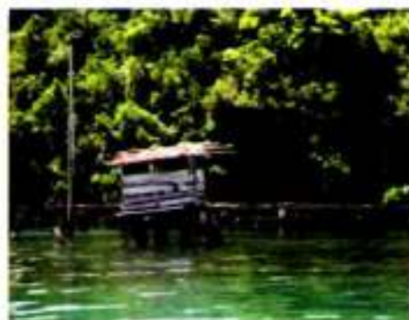
Foto 5. WC penduduk yang dibangun di atas perairan Teluk Youtefa
